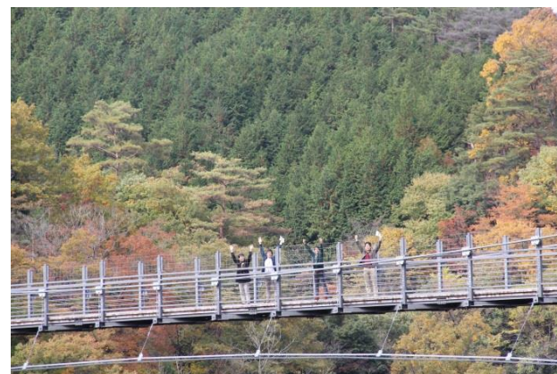
鬼の舌震 吊り橋
